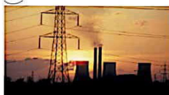
الكهرباء التي تنتجها محطة توليد الكهرباء هذه تُنقل بعيدًا عبر كابلات تنقل من أبراج كهرباء عالية.
