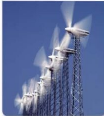
الشكل 22 تتحوّل طاقة الرياح إلى طاقة كهربائية عندما تُثقل المروحة الدائرة البوليد.
