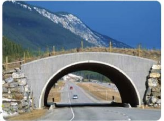
الشكل 20 توفر الممرات الممتدة بين أجزاء الموطن معبرًا آمنًا لمرور الحيوانات. هل ما مميزات الممرات وعيوبها؟
