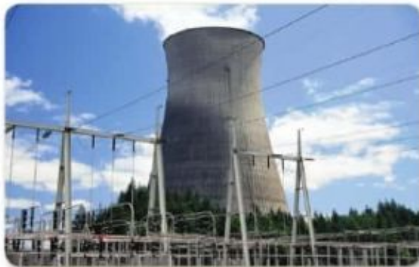
الشكل 10 تولّد محطة طاقة نووية كهرباء باستخدام الطاقة الحرارية الناتجة عن عملية الانشطار. هذا البرج الخرساني عبارة عن برج تبريد يعمل على إطلاق الحرارة المهدرة الناتجة عن تفاعل الانشطار.
