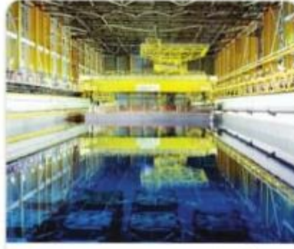
الشكل 16 يخزن الوقود المستند في حاويات مائنة للتبريد في محطات توليد الطاقة النووية ويغير غالباً في برك مخصصة خصيصاً لهذا الغرض.
