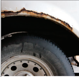
الشكل 9 تآكل هيكل هذه السيارة نتيجة تعرضه للماء والأكسجين عند اختيار المواد من الهام تقييم الظروف البيئية التي سيتم استخدام المادة فيها.
